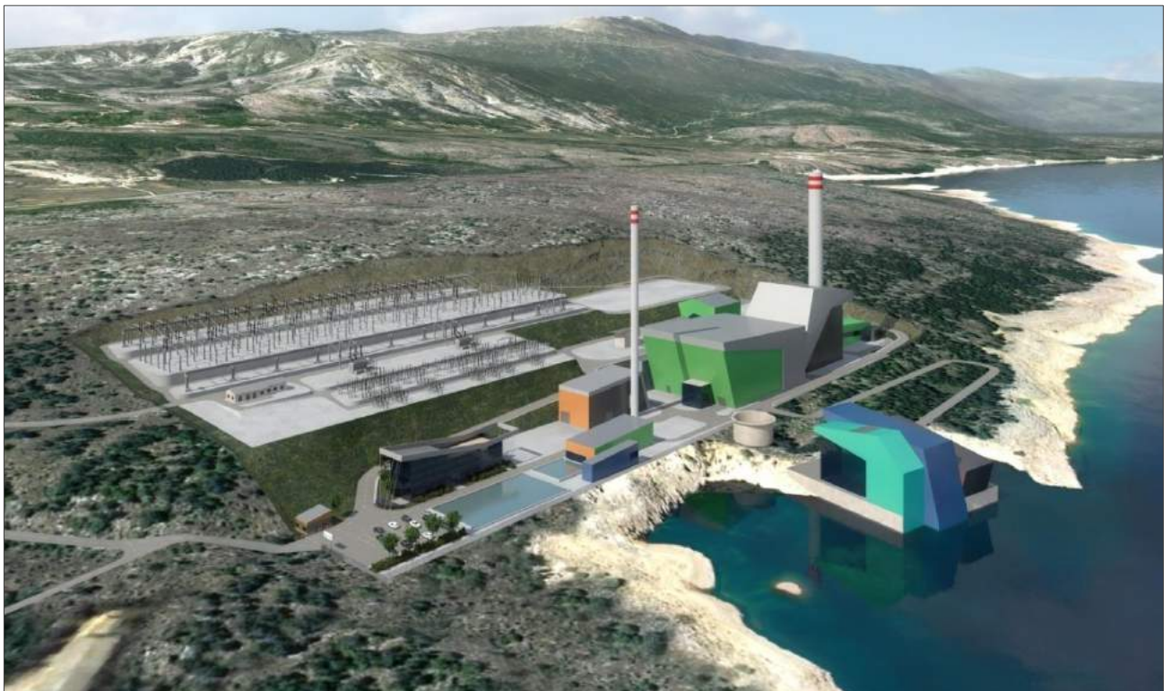
Slika 1.1.2: Simulacija izvedene KKPE Peruća uz jezero Peruća i rasklopište TS Hrvace (pogled na samu lokaciju na obronku brda Derven, preko područja naselja Potravlje dalje prema zapadu i planini Svilaji).
